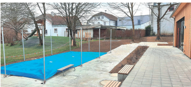
Außenbereich, auf die hintere Pflasterfläche kommt noch ein Geräteschuppen
