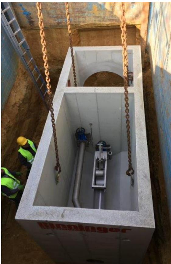
Einbau des Drosselbauwerks zur kontrollierten Ableitung des Abwassers
