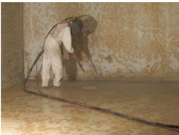
Die alte Beschichtung wird weggestrahlt
