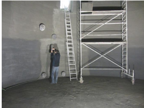
Erneuerung der Innenbeschichtung
