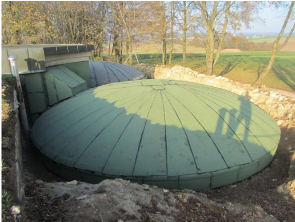
Neu abgedichteter Rundbehälter
