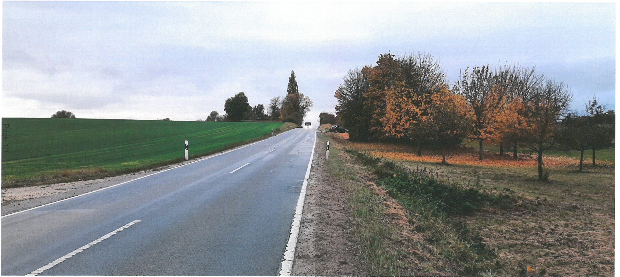
Anlage A: Seebug Richtung Süden, der geplante Radweg verläuft rechts entlang der Straße
